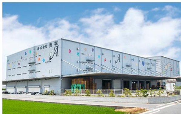
【本社島原A倉庫】
